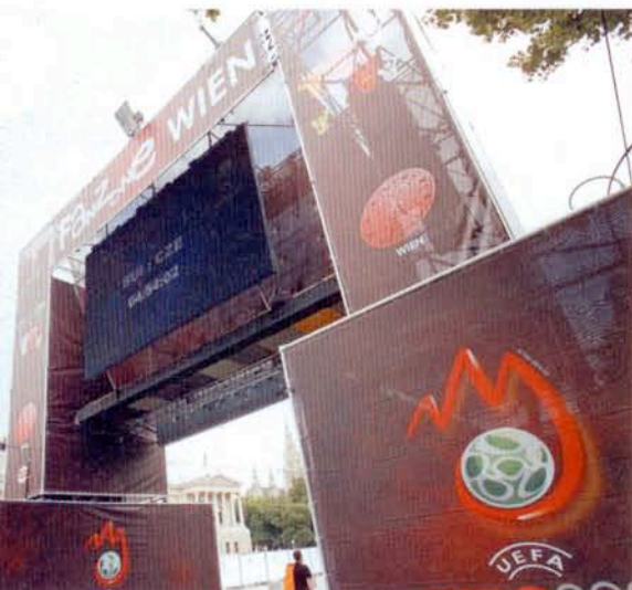
Auf dem Ring nahe am Parlament; rechts oben sind hinter der Bespannung zwei Lautsprecher-Arrays zu erkennen, welche in entgegengesetzte Straßenrichtungen schallen
