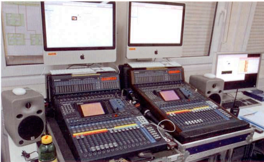
Als Mischpulte bzw. digitale Verteiler/Router dienten im Sicherheitszentrum zwei digitale DM1000-Pulte von Yamaha
